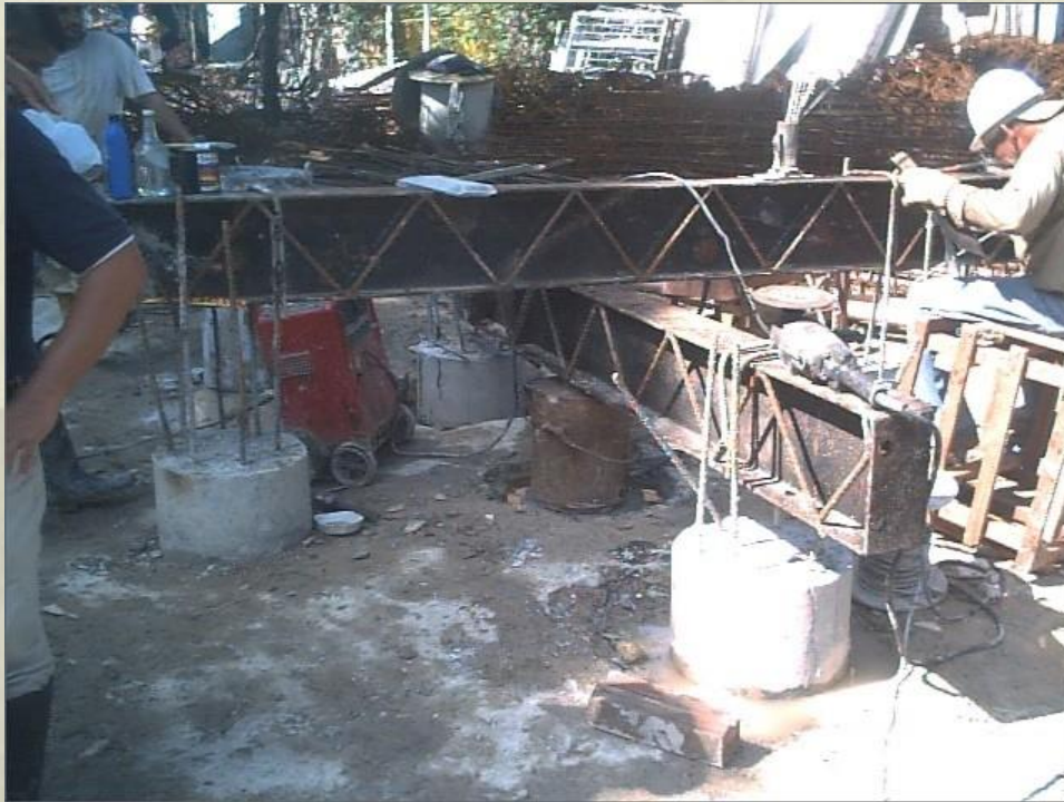
Pruebas de Carga Sobre Pilotes
