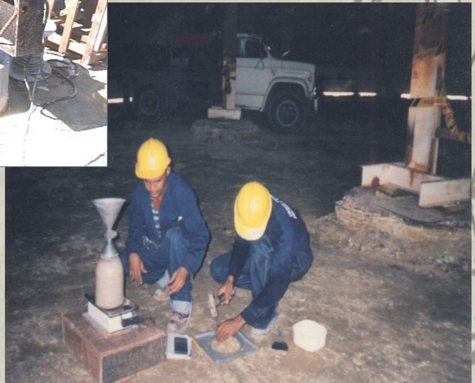
Control de Compactación en Campo ( Densidades )
