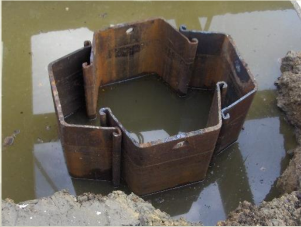
Hincado de Tablestaca
