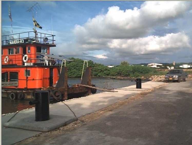
Reparación y Construcción de Muelles y Bitas de Amarre
